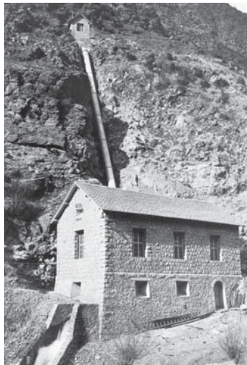
Central en construcció 1932. © FEDA
