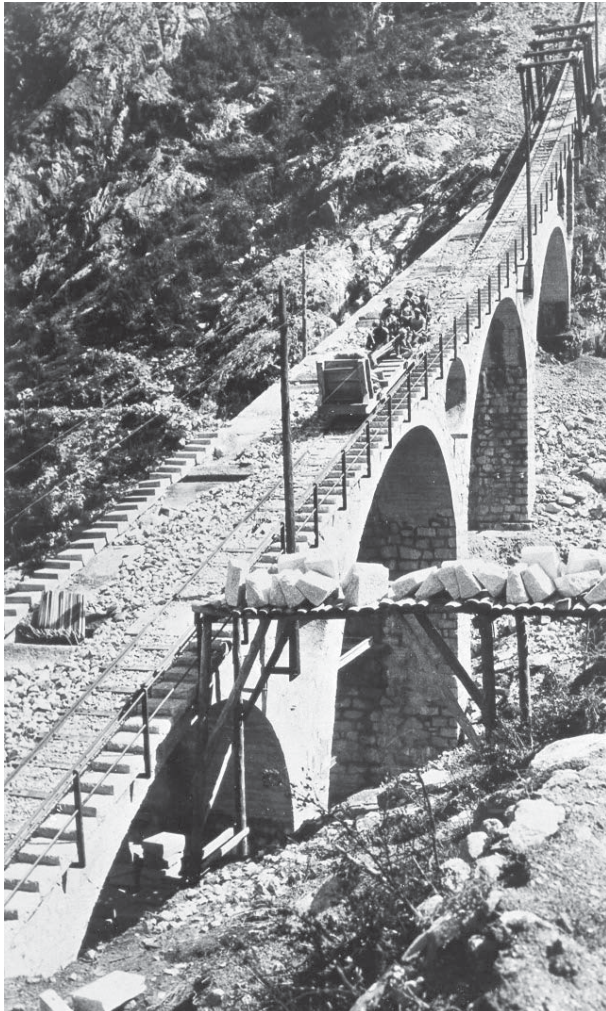
Pont Tresoles en construcció 1932. © FEDA
